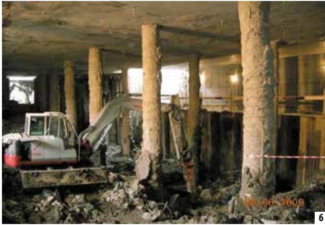
Общий вид строительной площадки строительства, метод «Топ-Даун» (а) и разработка котлована под плитой перекрытия при устройстве 2-го подземного этажа (б)
