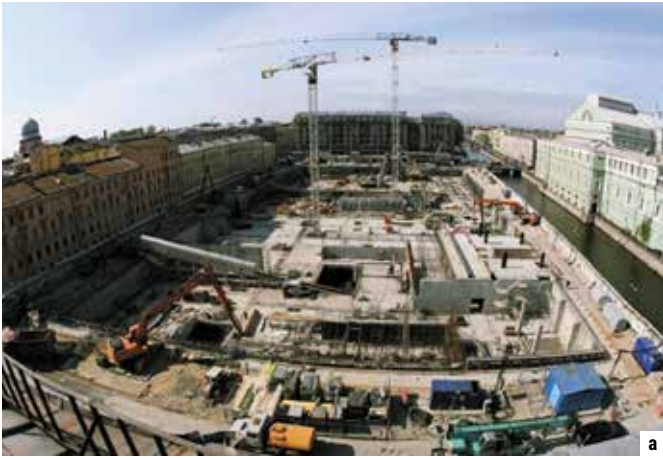
Общий вид строительной площадки строительства, метод «Топ-Даун» (а) и разработка котлована под плитой перекрытия при устройстве 2-го подземного этажа (б)
